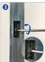
Madenschraube wieder festziehen.
