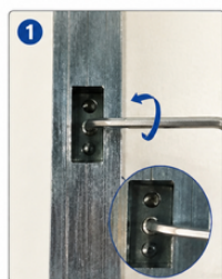
Madenschraube mit einem 1,5-mm-Inbusschlüssel leicht lösen.
